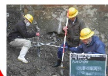
↑社内完成検査状況
